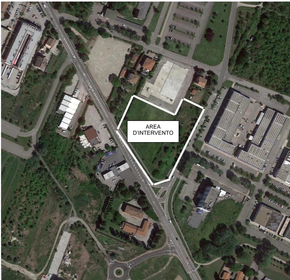
Figura 1 – Inquadramento geografico dell'area di intervento
